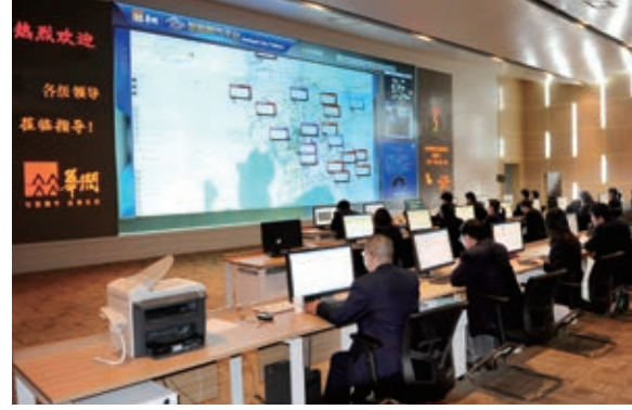
無錫華潤燃氣指揮中心現場 Wuxi CR Gas Command Center
